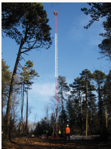
installation d'un mat de mesure.
